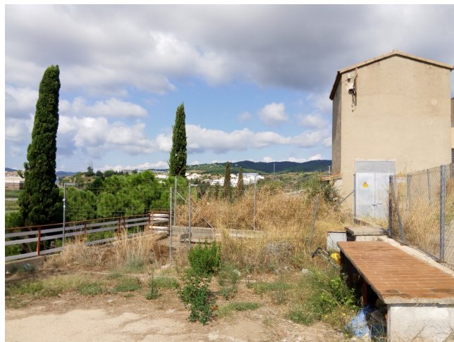
Límit nord, amb l'estació transformadora al fons, a l'exterior
