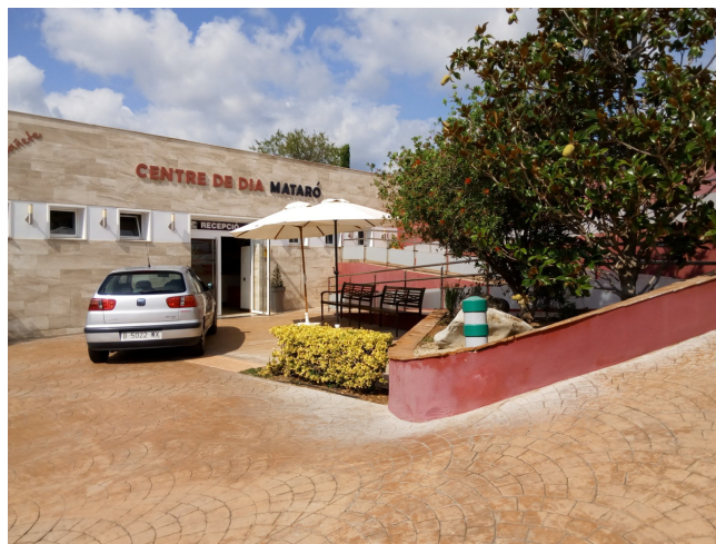
Accés a l'edifici, a la planta primera
