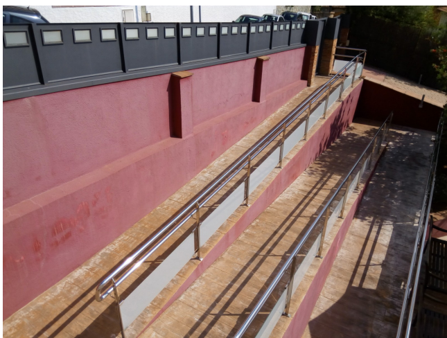
Rampa d'accés per a vianants
