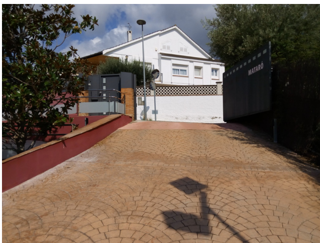
Rampa d'accés per a vehicles
