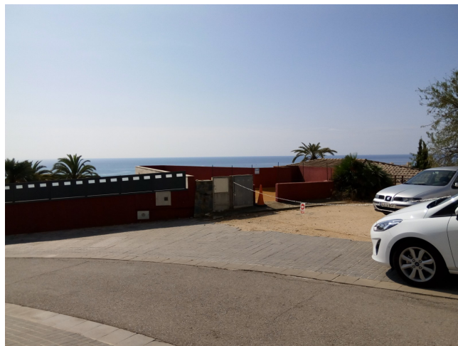
Coberta plana i inclinada de l'edifici, i aparcament privat
