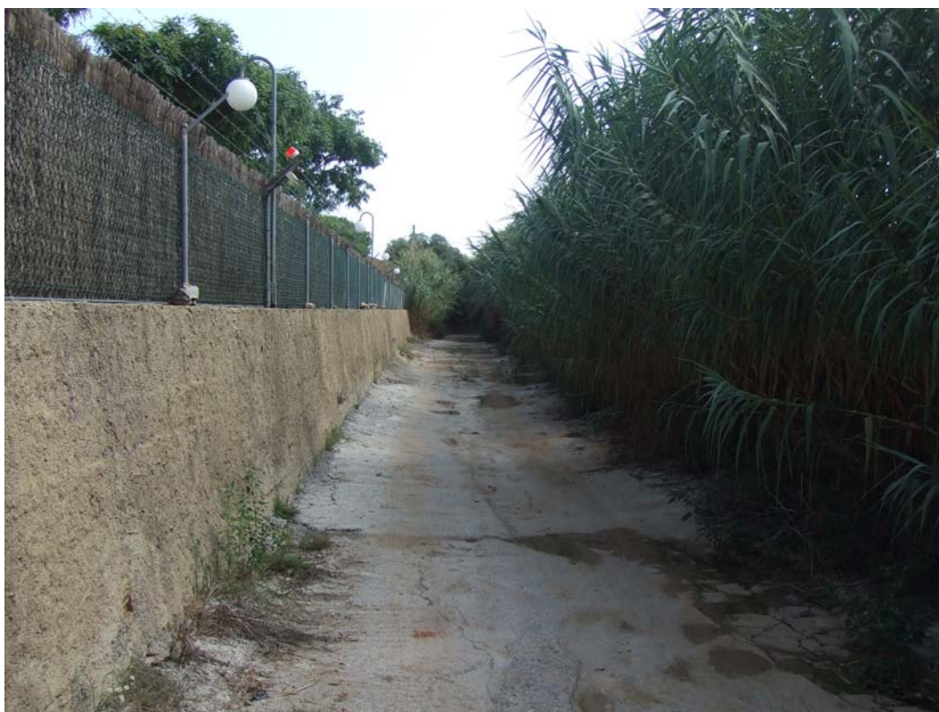
Foto 5: Vista aigües avall de la llera a l'alçada de la secció 229,11. S'observa al marge esquerre el mur perimetral de l'actual Càmping Barcelona.
