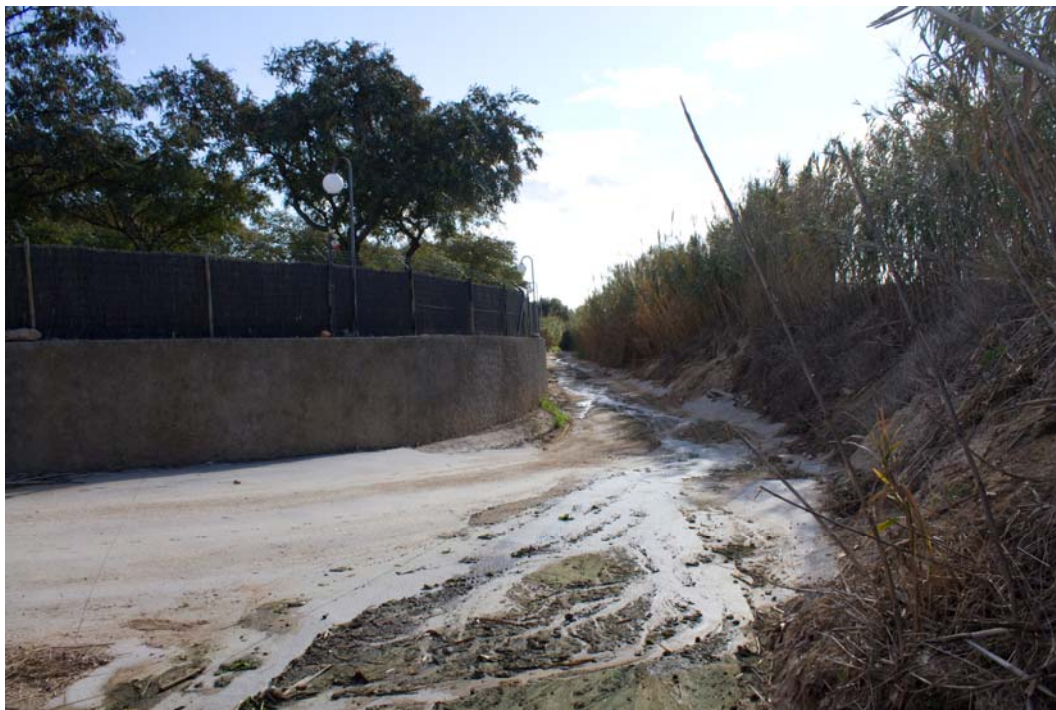
Foto 3: Vista aigües avall de la llera a l'alçada de la secció 329,1. En aquest punt la llera passa a ser un camí d'accés a les finques circumdants i s'observa el mur perimetral de l'actual càmping Barcelona.
