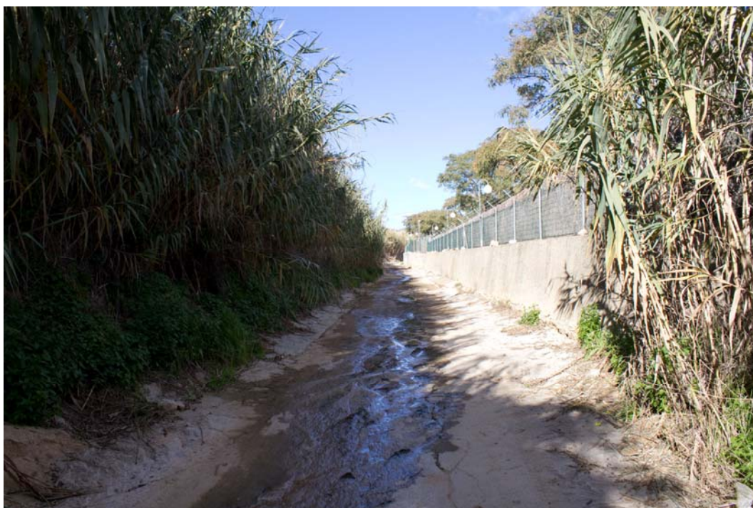
Foto 6: Vista aigües amunt de la llera a l'alçada de la secció 178,33. S'observa al marge esquerre el mur perimetral de l'actual Càmping Barcelona.
