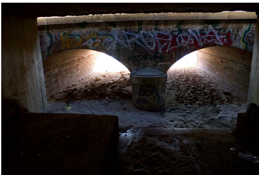
Foto 11: Vista detall de l'obra de pas per sota la vies del ferrocarril
