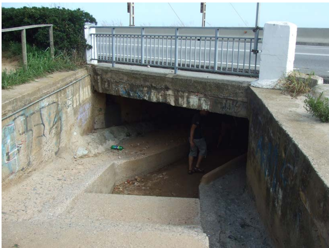
Foto 10: Vista detall de l'obra de pas per sota la carretera N-II.
