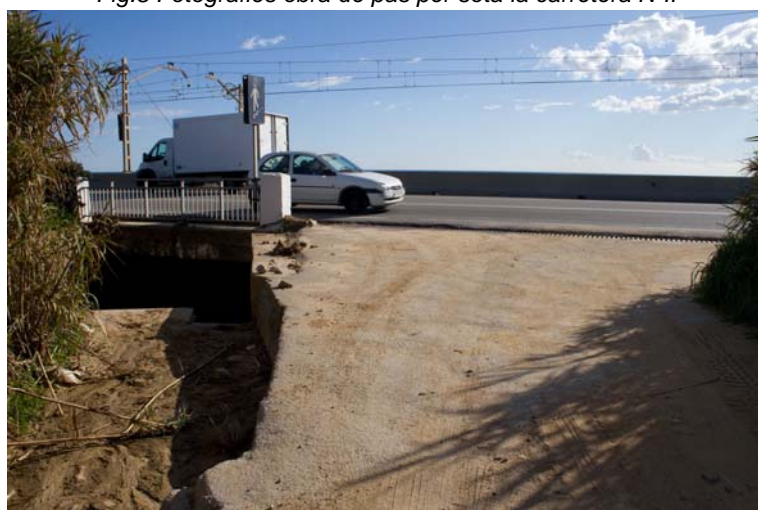
Fig.8 Fotografies obra de pas per sota la carretera N-II
