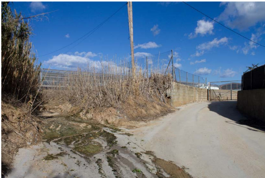
Foto 4: Vista aigües amunt de la llera a l'alçada de la secció 323,7. S'observa un accés a la zona dels hivernacles actuals i el punt on la llera passa a ser un camí parcialment pavimentat.
