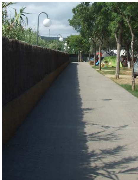
Fig.11 Fotografia camí interior paral·lel al mur perimetral
