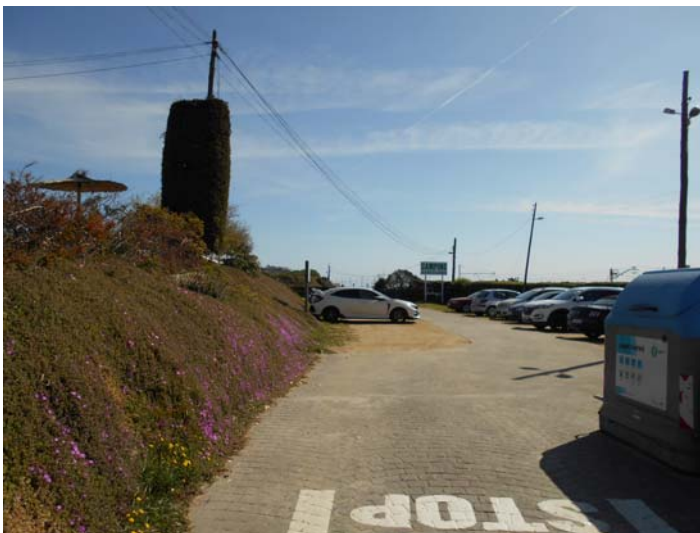
Fotografia 2. Frontal de l'àmbit, corresponent a la zona d'aparcament entre la piscina i la N-II.
