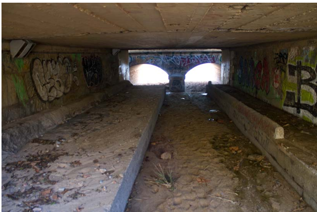
Foto 11: Vista detall de l'interior de l'obra de pas per sota la carretera N-II. Al fons s'observa l'obra de pas per sota la vies del ferrocarril
