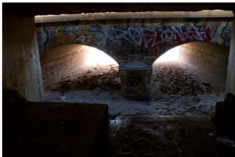
Fig.10 Fotografia detall obra de pas per sota les vies del ferrocarril
