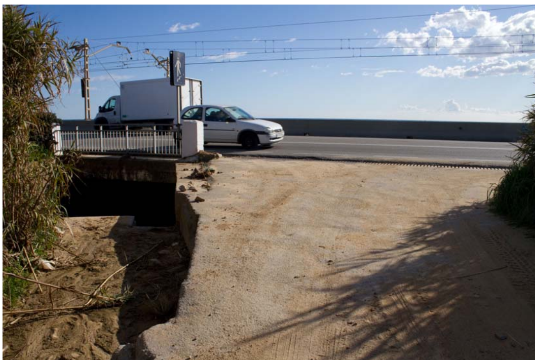
Foto 9: Vista aigües avall de la llera i la seva incorporació a l'obra de pas per sota la carretera N-II.
