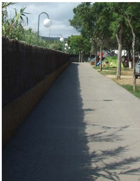
Fig.11 Fotografia camí interior paral·lel al mur perimetral
