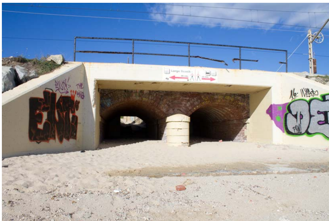
Foto 11: Vista de la sortida de l'obra de pas per sota les vies de ferrocarril
