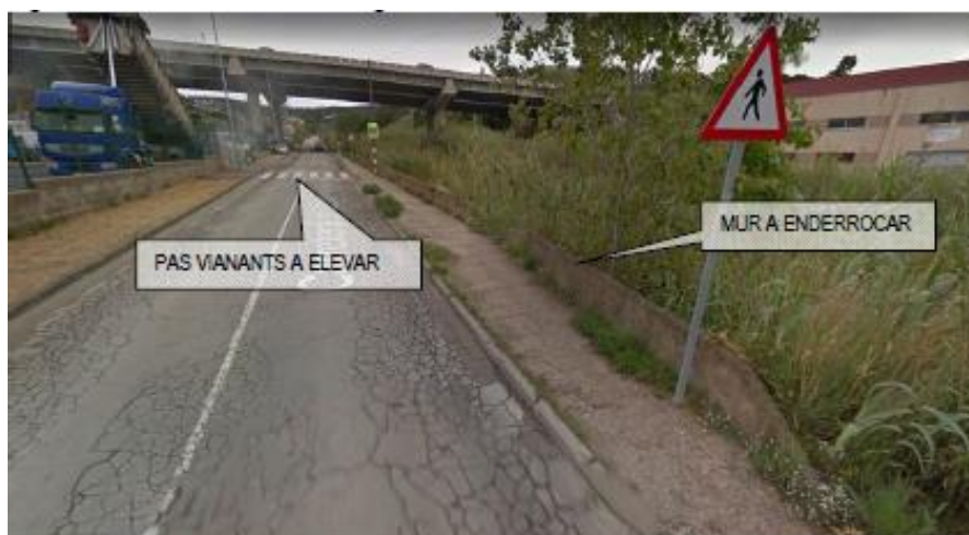
Fig.2. Mesures correctores a implementar al llarg de la Carretera de Valldeix, entre el gual de connexió de la Carretera de Valldeix i el polígon industrial Vallveric i els Jardins de les Víctimes de la Batalla de l'Ebre, per tal de facilitar la incorporació, un altra cop a la llera, de l'aigua que pugui desbordar de la riera de Sant Simó (cal recordar que el pendent transversal de la Carretera de Valldeix és d'aproximadament el 2% cap a la riera). Font: Estudi hidràulic de la riera de Valldeix des d'aigües amunt de la C-32 fins al camí de les Cinc Sènies. Agost de 2018.
