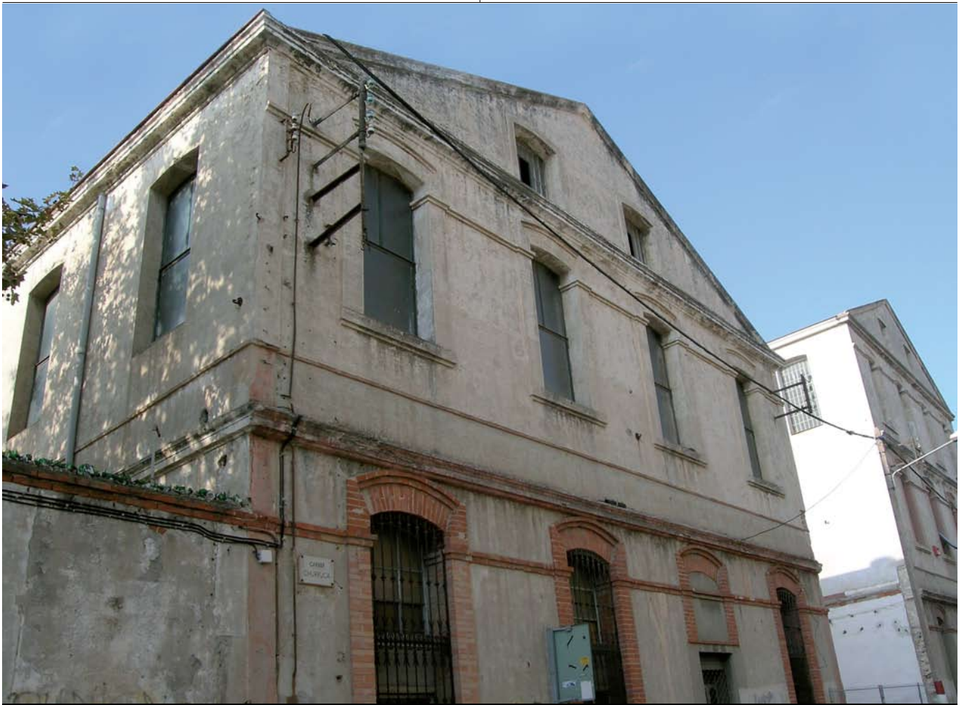
La rehabilitació d'una de les naus de la fàbrica Cabot i Barba s'iniciarà amb la reforma de les façanes i la coberta.
