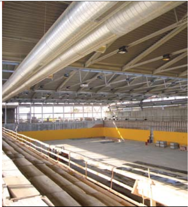
Estat de les obres del futur poliesportiu del carrer d'Euskadi.
