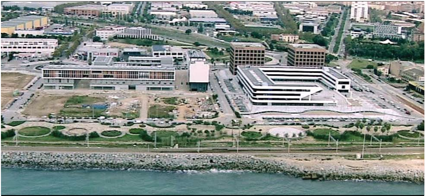
El sector del Rengle ha experimentat una gran transformació amb l'edifici per a empreses, serveis i comerç, el nou hotel i el TecnoCampus.
