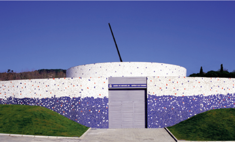
Façana del dipòsit Els Turons
