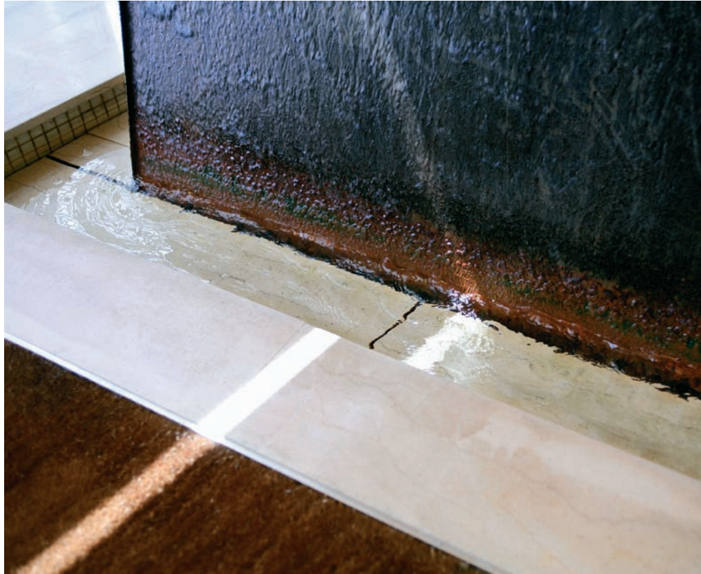
Base font ornamental de l'entrada principal d'Aigües de Mataró
