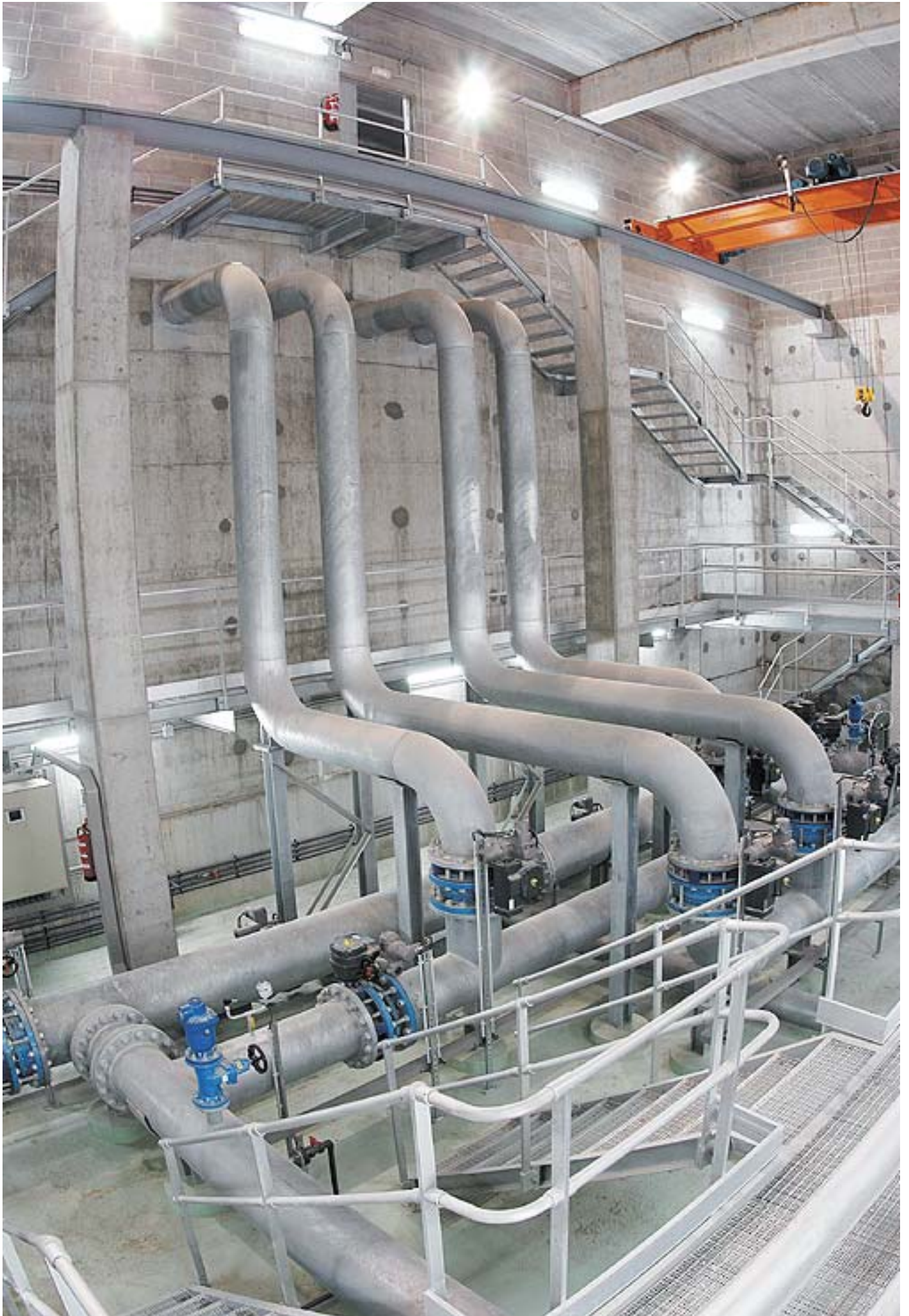
DIPÒSIT DE ROCABLANCA
