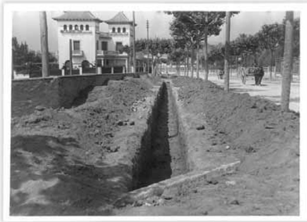
FEINES DE CANALITZACIÓ AL CAMÍ DE LA GEGANTA. ANY 1953
